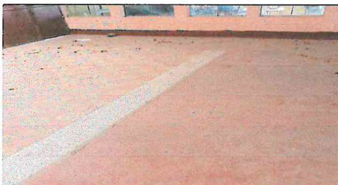
Foto 3: sustitución de torta concreto por piso ceramica en escenario 6.8
