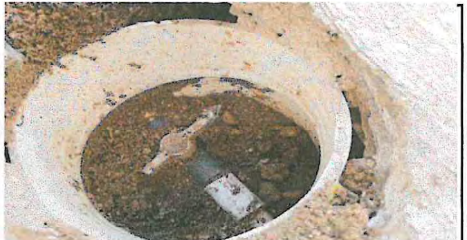
Foto 6: sustitución llave de paso
