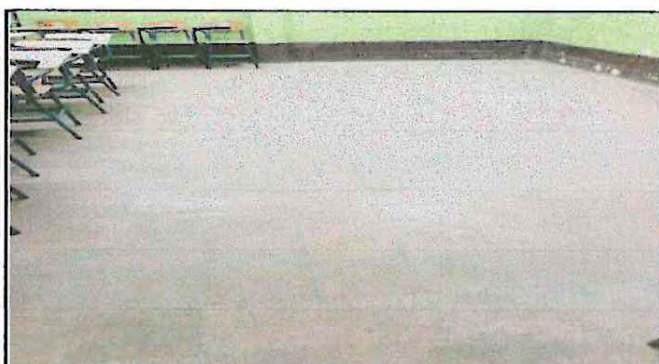
Foto 4: sustitución de torta concreto por piso ceramico en aula 6.8
