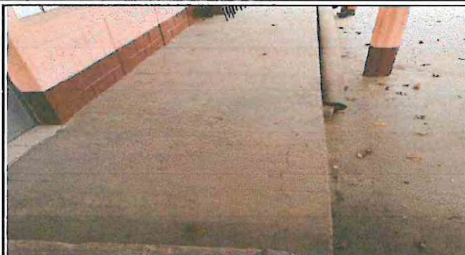
Foto 1: Sustitución de torta concreto por piso ceramica en corredores 6.8
